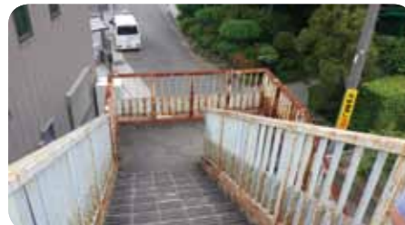
劣化が著しい延沢歩道橋
