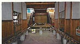
ジャッキアップの準備
