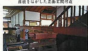
ジャッキアップのため校舎内を通る鉄骨
