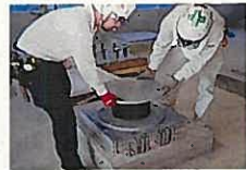
免震装置を設置
