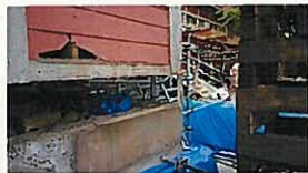
校舎のジャッキアップ
