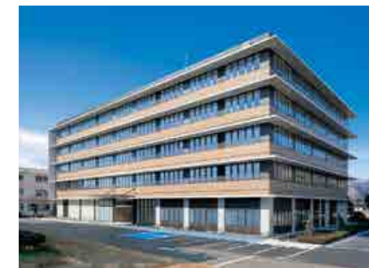
完成した新本館
