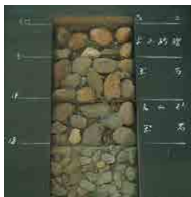
▲1973年の第2浄水場の建設資料 火山砂礫と火山砂が見られる
