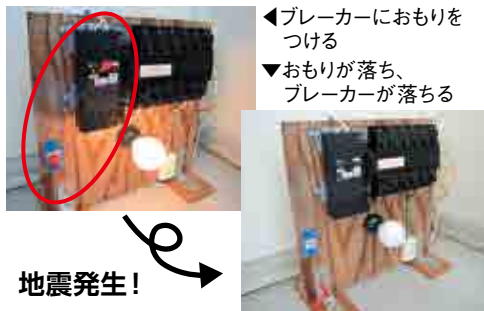
感震ブレーカーの仕組み(星野さん製作の模型を参考)
