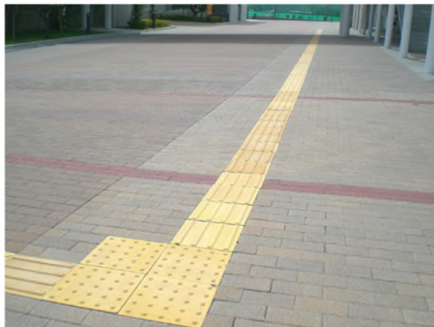
アプローチ 校門から事務室受付まで視覚障害者誘導用ブロックを敷設しています。
