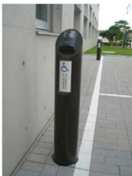
インターホン 車いす使用者用駐車スペースに設置されたインターホンで事務室に連絡ができます。
