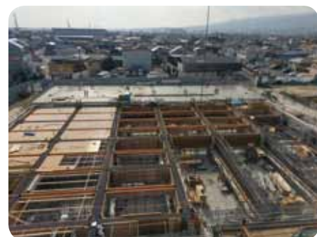
現在の工事風景
