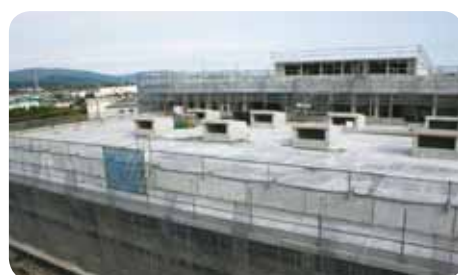
現在の工事風景
