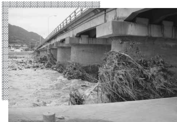
上流から流れてきた枝などがからみついた十文字橋橋脚 (写真提供：井上三男氏)
