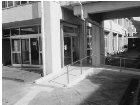
玄関付近の改修状況
