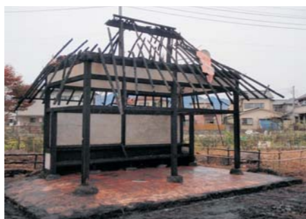
全焼したあじさい公園内休憩所
