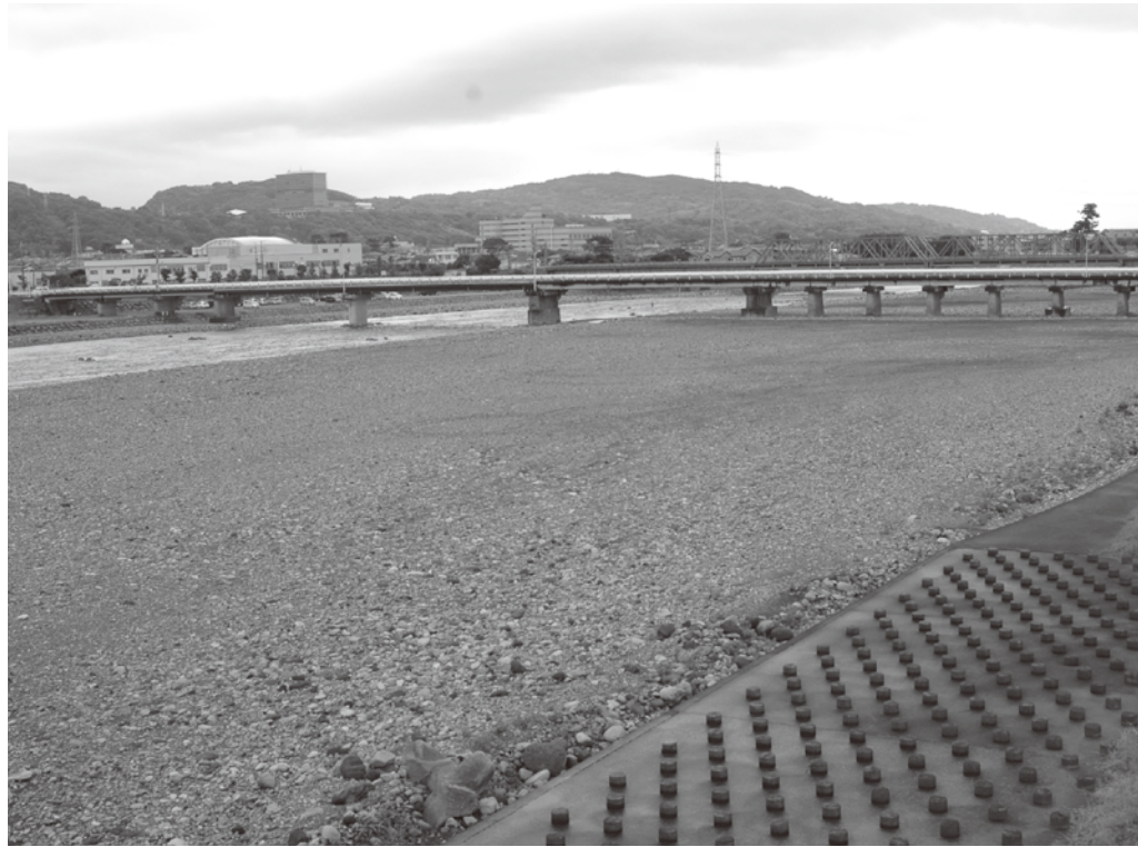
河川内に堆積した土砂が撤去された酒匂川
