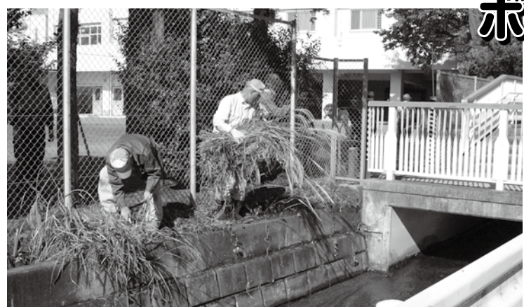
開成小学校脇にある水路の清掃
