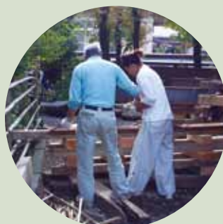
工事現場で技術継承
