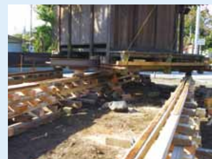
曳家の工事現場
