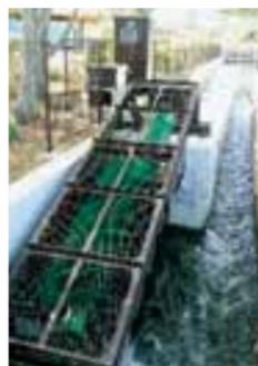
町では今年3月、あじさい公園東側の武永田用水路内に、小水力発電所を設置しました。県内初の「開放型らせん水車」を用いた発電設備です。地球温暖化を受けて、二酸化炭素削減の機運が高まったことや、平成23年3月に未曾有の被害をもたらした東日本大震災を契機に、再生可能エネルギー活用が普及啓発が求
