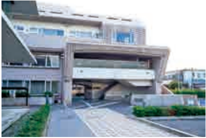
町民センター改修工事 2 億 1348 万円
