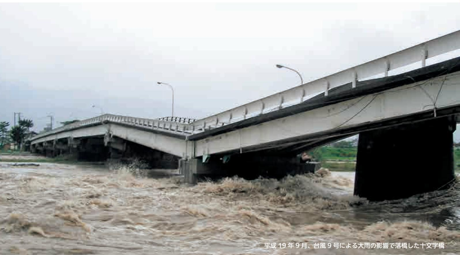
平成19年9月、台風9号による大雨の影響で落橋した十文字橋
