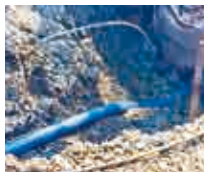
◀地震による地面のズレに追従する水道管のようす
