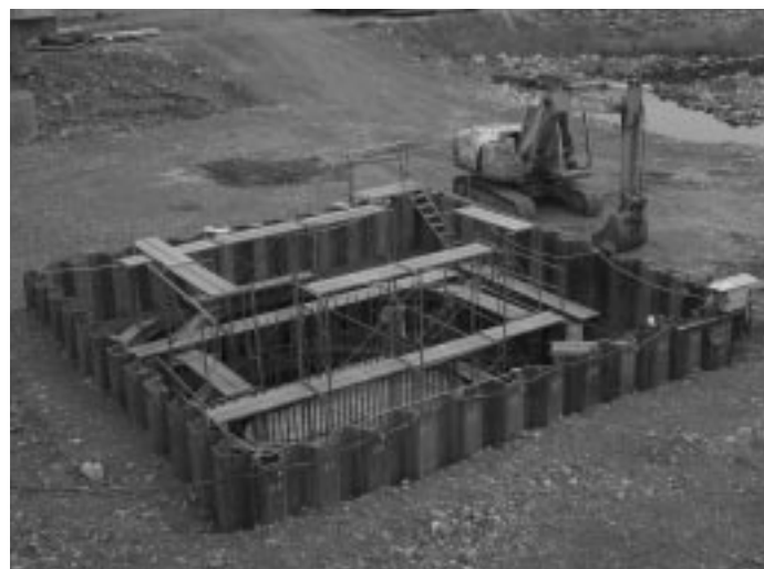
4段のうち2段目で姿を現した橋脚。鉄筋組み立て→枠組→コンクリート打設→養生を繰り返し、7月末には橋桁近くまで立ち上がる予定
