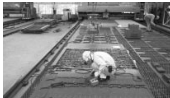
車道部の橋桁は工場で作られています
