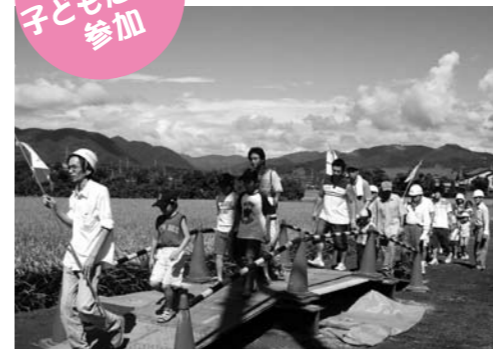
仮設橋設置訓練
