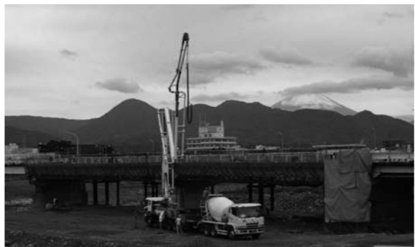
全面開通に向けて工事が進む橋桁全景(11月11日 松田町側から撮影)
