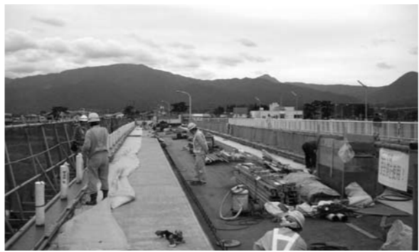
修復の進む歩道部の橋桁(11月11日 松田町側から撮影)
