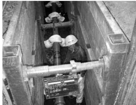
上水道と下水道の工事時期を合わせることで経費削減
