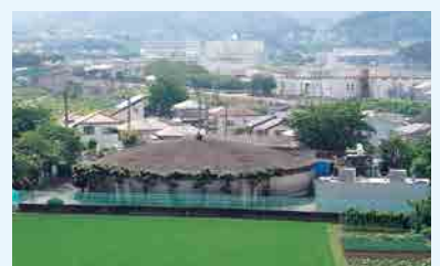
高台第一浄水場
