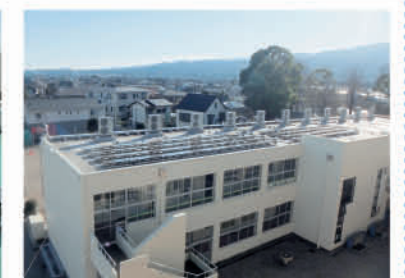
文命中学校の太陽光発電設備
