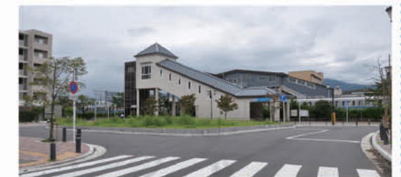
改修した駅東口ロータリー
