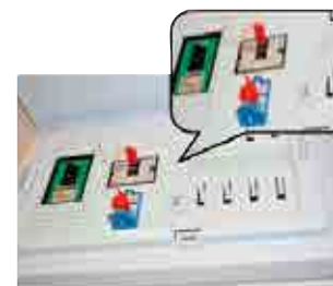
ブレーカーにおもりをつける
