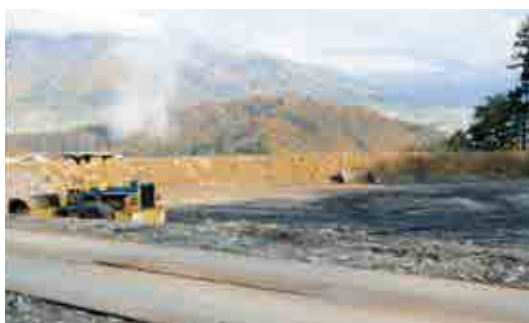
長野県にある最終処分場
