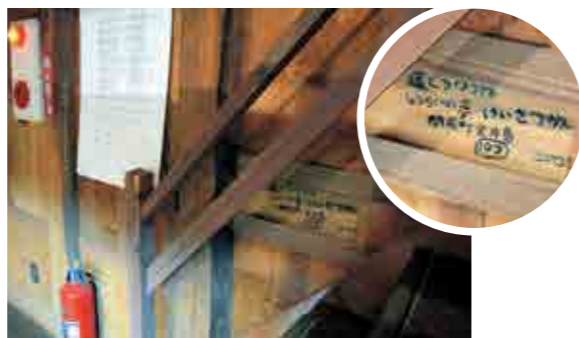
メッセージが書かれた土蔵内部の壁板の下地
