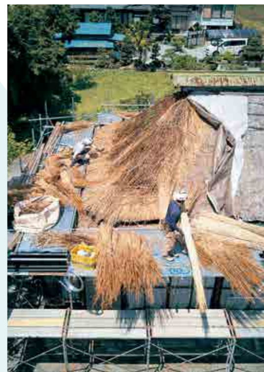
今回は、屋根の葺きを補修した
