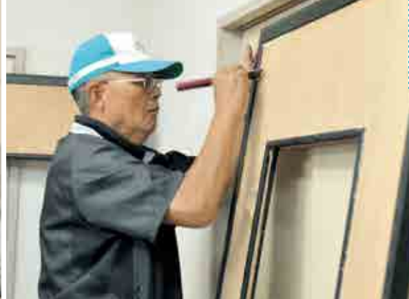
▲古い襖紙を丁寧にはがす角張さん。古いのが少しでも残っていると、きれいな仕上がりにならない。
