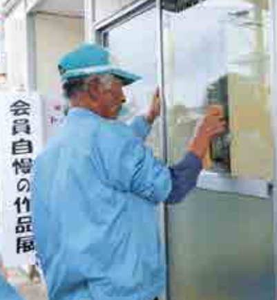
▲新たに組み立てているフィルム張り。気泡が入らないよう細心の注意を払う。
