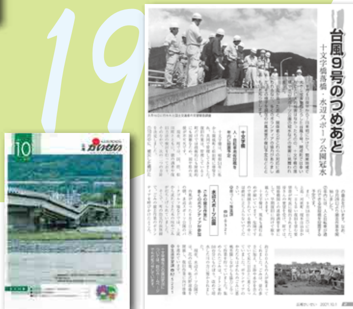
▲落橋した十文字橋。水害の恐ろしさを痛感した。早期復旧に向け、多くの人が尽力した様子を伝えた。 (平成19年10月号) 4
