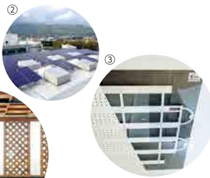
①あじさいパネル②屋上にある太陽光パネルと天窗③冷温水を天井や床に通すためのチューブ。エアコンよりも自然な涼しさ(暖かさ)を感じることが出来る。
