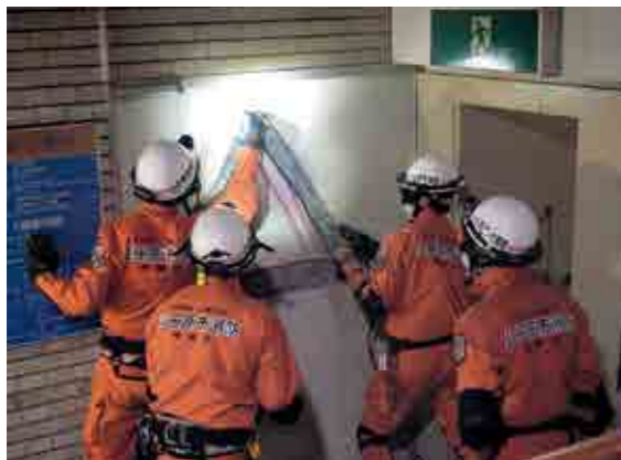
▲壁を破壊して行った救出救助訓練
