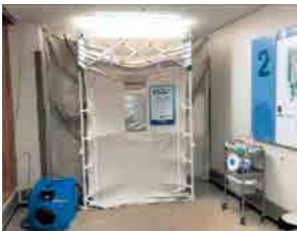
▲一般病棟にも陰圧装置を設置。気圧を下げることで、部屋内部のウイルスを含んだ空気が外部に漏れないようになる。 ▶個室化した救急外来ブース。発熱患者は原則として隔離して対応している。 ※写真提供:神奈川県立足柄上病院
