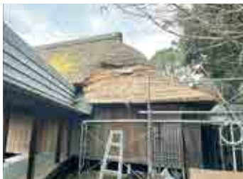
▲苔が生えやすい西裏側の屋根から修繕を始めている。
