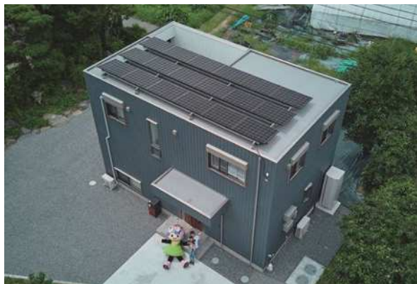
太陽光発電設備を導入した住宅
