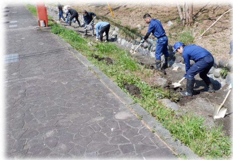
▼吉田島4372-1先土砂上げ状況 延長 20m 程度
