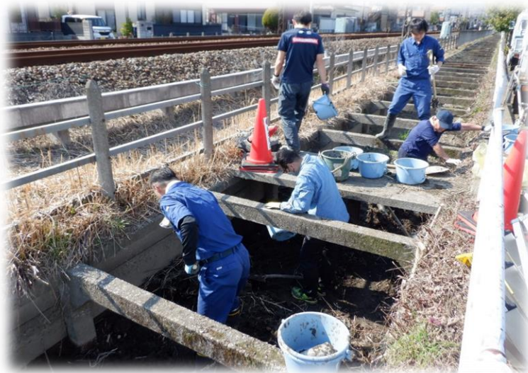
▼吉田島3503-3先土砂上げ、河床整理状況 延長 150m 程度
