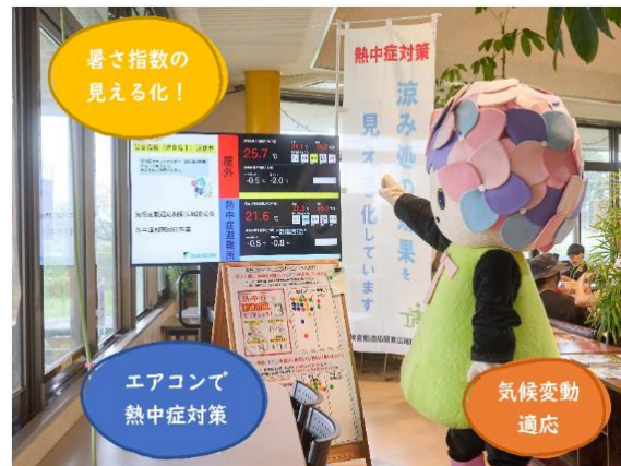
図3-17 暑さ指数を示すモニターの設置状況
