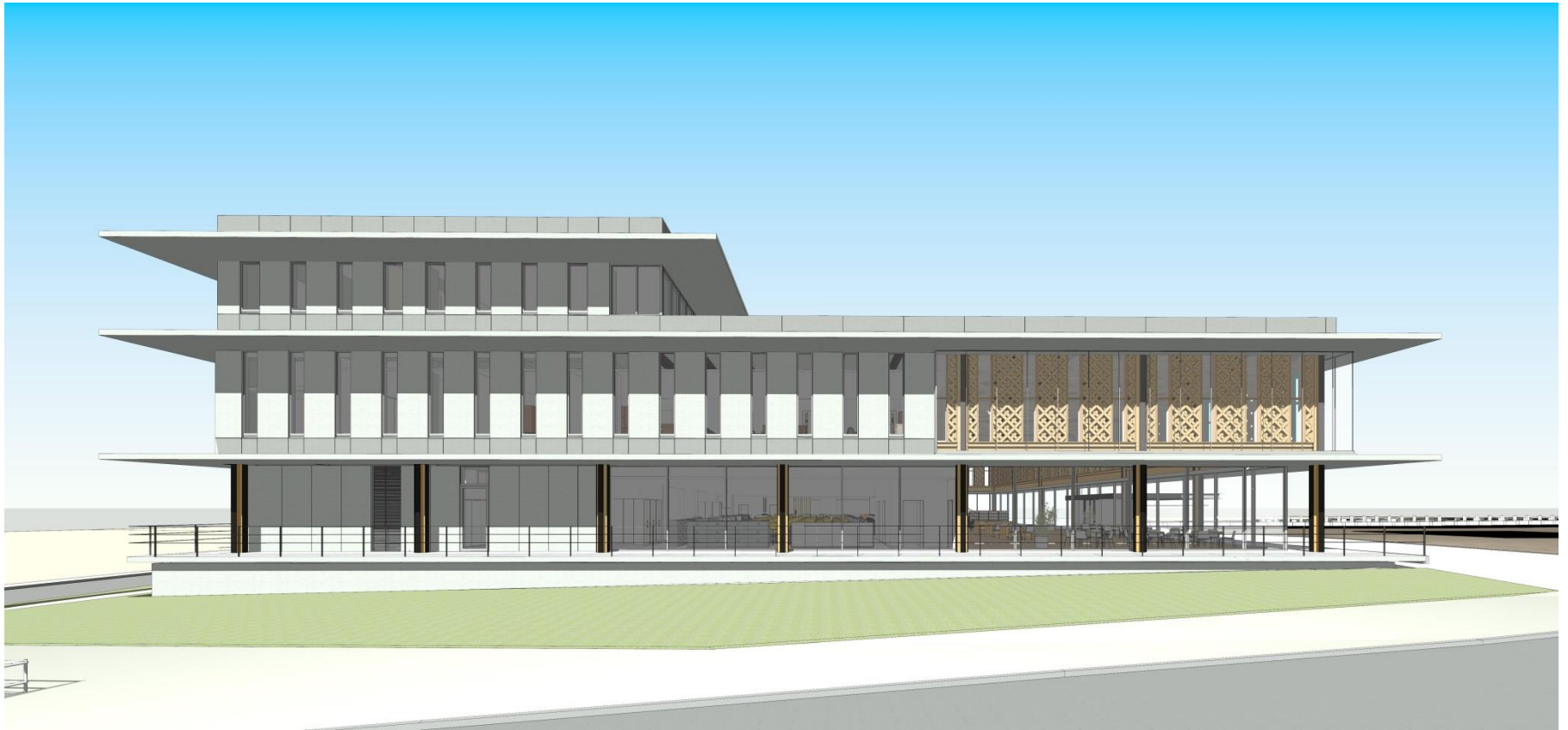
東側からの外観
